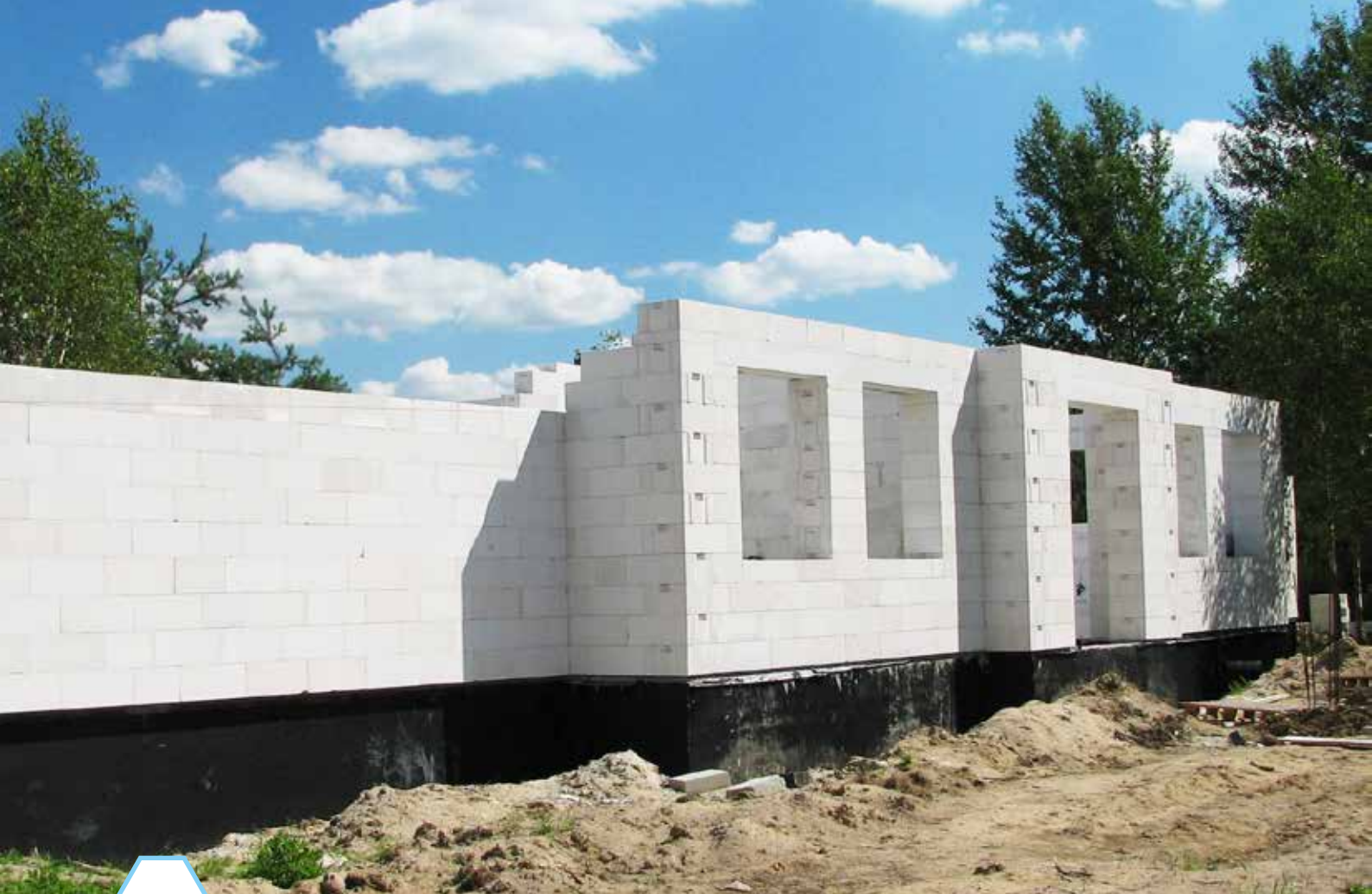
Ilustracja 42: Ściany z bloczków z betonu komórkowego
