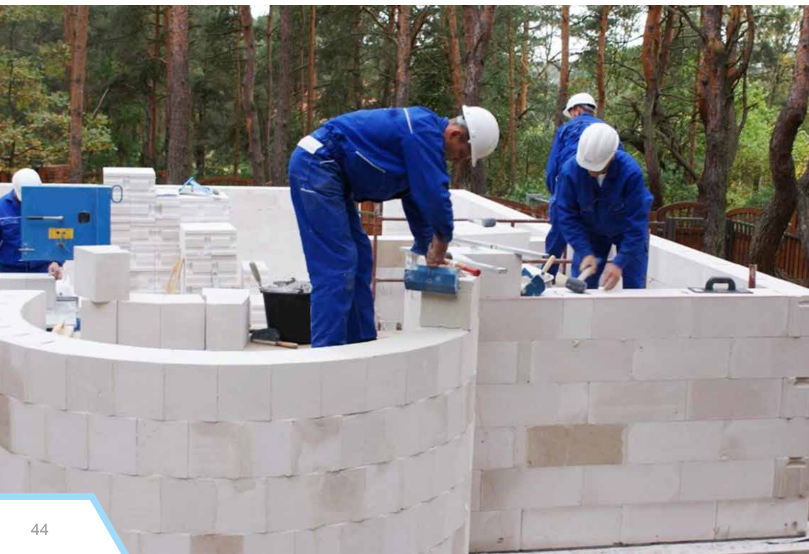
Ilustracja 42: Ściany z bloczków z betonu komórkowego
